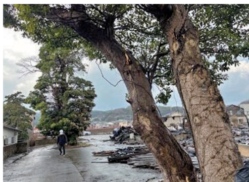
写真3 焼失範囲最南部の焼け止まり
