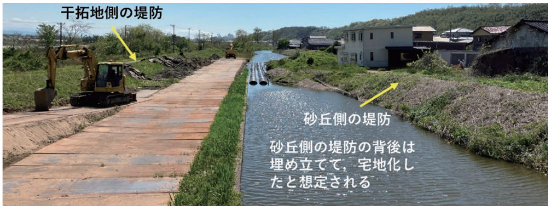
写真1 西部承水路と兩岸の堤防（室橋から南西方向を望む）
