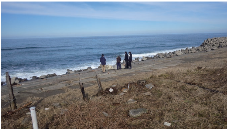
写真2 津波の遡上痕跡付近の汀線の状況 (大潟海岸, 図12左)
