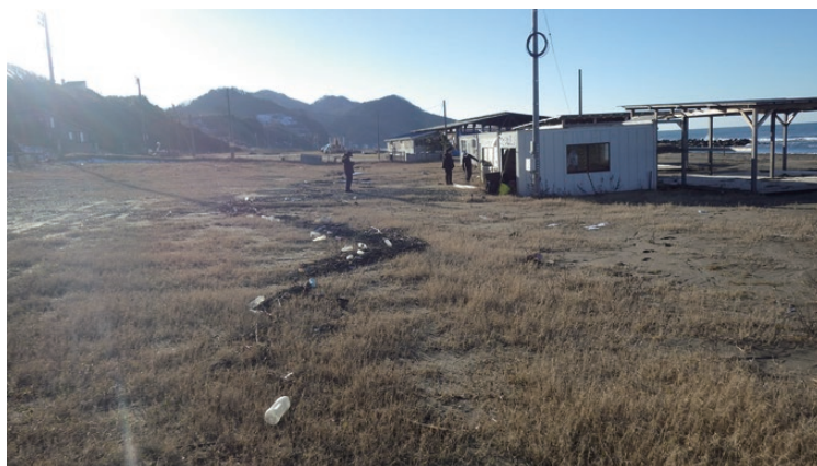
写真4 直江津海水浴場、建物陸側の状況
