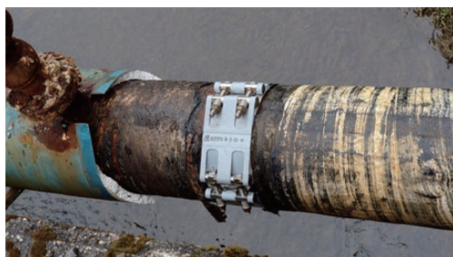
(b) 漏水補修箇所
