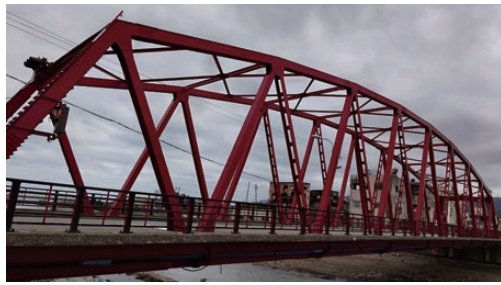
(a) 水管橋全体
