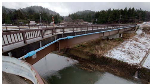
(a) 水管橋全体
