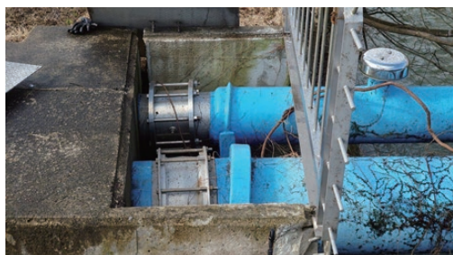
(b) 曲げと圧縮を受ける円筒摺動型継手
