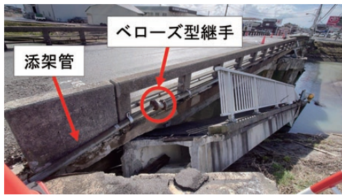
(a) 水管橋全体
