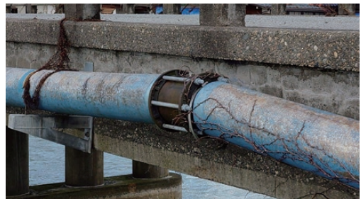
(c) 屈曲した円筒摺動型継手
