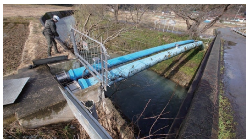
(a) 水管橋全体
