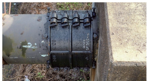
(d) 漏水補修箇所
