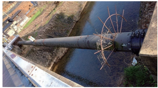
(a) 水管橋全体
