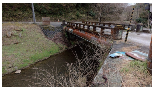
(a) 水管橋全体
