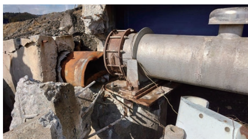
(c) 脱管した円筒摺動型継手
