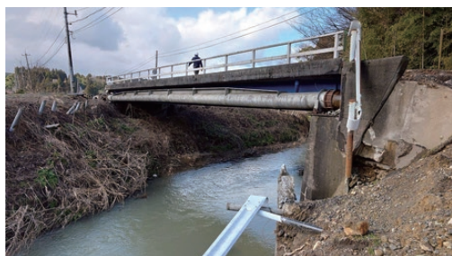
(a) 水管橋全体
