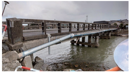
(a) 水管橋全体
