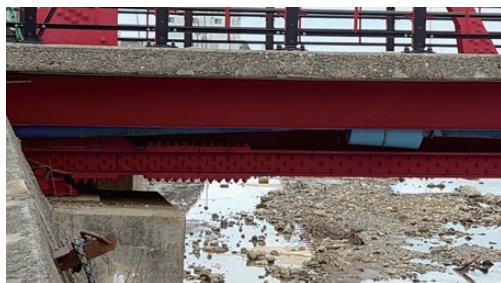
(c) 添架管伸縮可撓継手
