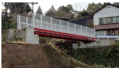
(a) 水管橋全体
