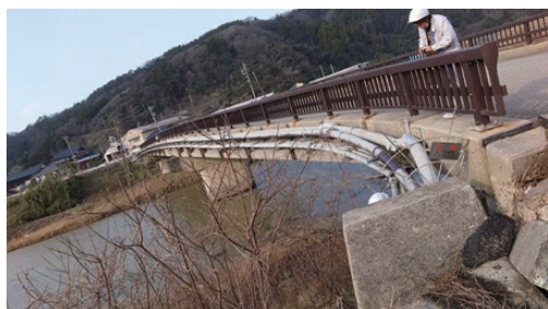
(a) 水管橋全体
