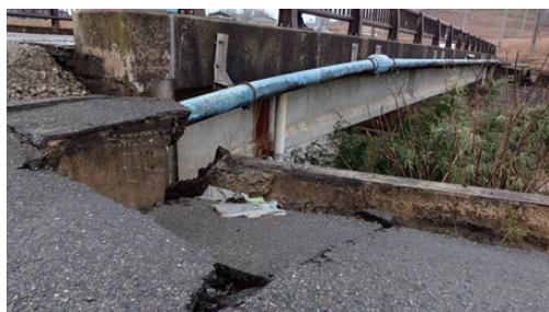
(a) 添架鋼管路
