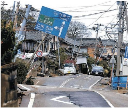
図13 内灘町の液状化による被害<sup>16)</sup>
