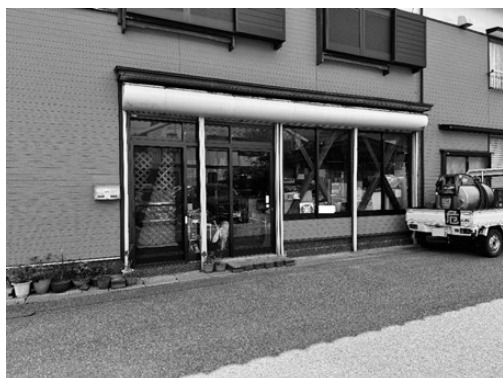
写真1 耐震補強した店舗併用住宅（輪島市）
