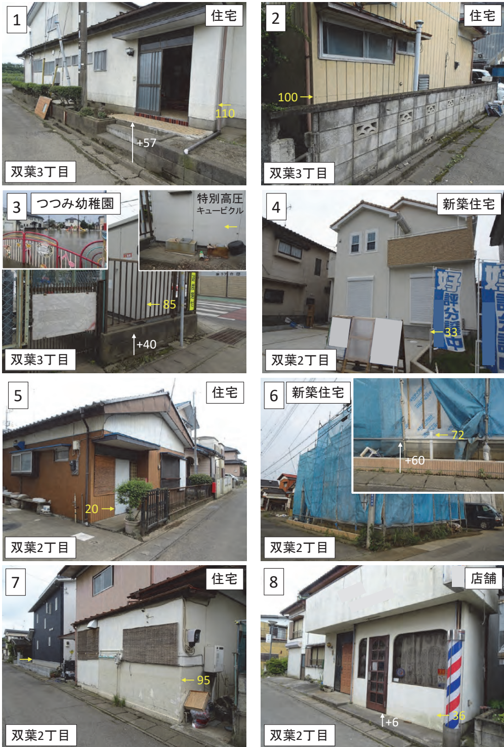
写真1 取手市の双葉地区における浸水深(浸水痕跡)の状況(地盤からの高さ, cm)
