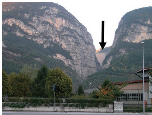
図1 Longarone 村から見上げた峡谷に築造されたヴァイオントダム(矢印)
