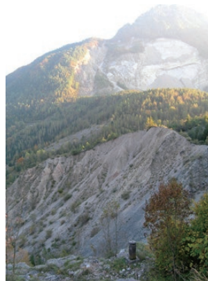
図2 ヴァイオントダムに落下した土塊(前景)と斜面崩壊のすべり面(背景上部)
