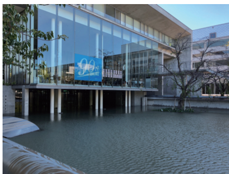
浸水状況 (10/13撮影)
