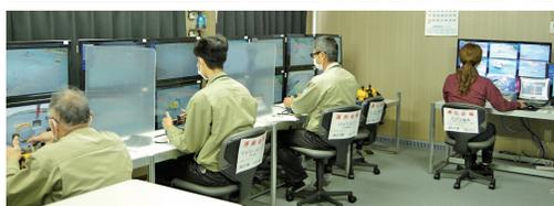
写真3-1 地元企業による無人化施工除石の実施状況
