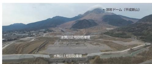
写真2-2 水無川1号・2号砂防堰堤の嵩上げ工事完成間近の状況
