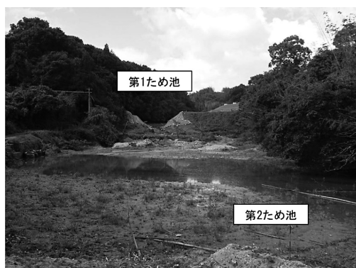
写真1 西分第1および第2ため池の被害状況
