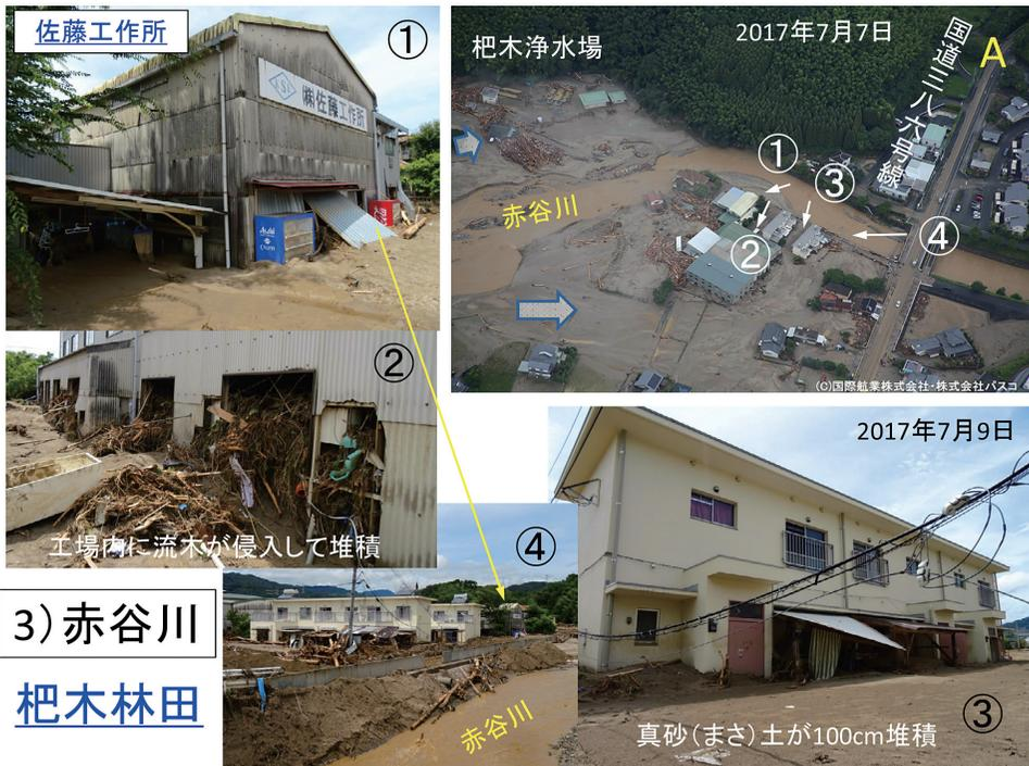
写真6 赤谷川流域(杷木林田地区)の被害状況
