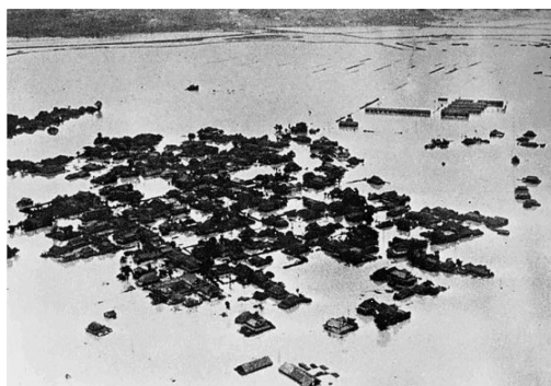
写真2-3 浸水状況(小野島地区) 出典) 本明川水系河川整備計画(変更) 3)
