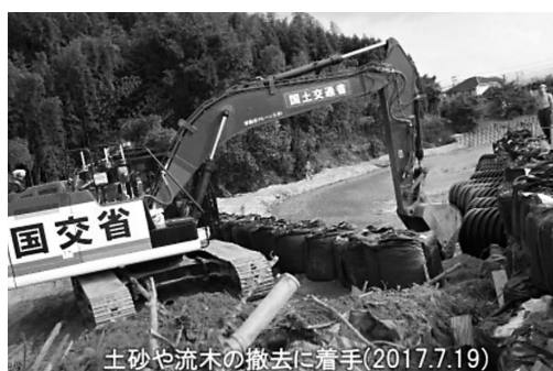
写真10-9 土砂や流木の撤去状況
