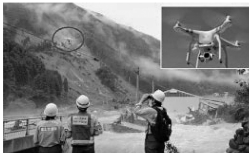
写真10-3 TEC-FORCE によるドローン調査
