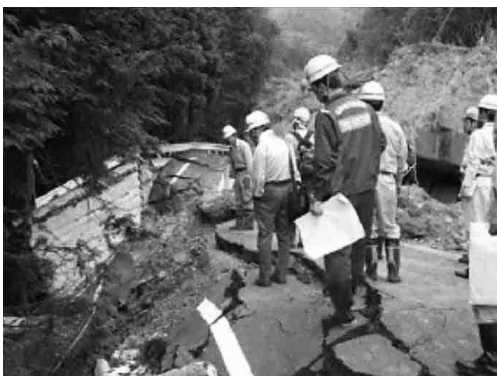
図10-6 学識経験者，整備局職員による被災調査
