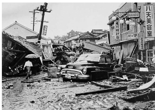
写真2-4 家屋倒壊の状況(八天町) 出典) 本明川水系河川整備計画(変更) 3)
