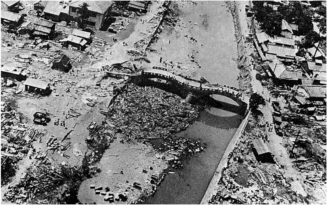
写真3-1 眼鏡橋の被災状況 (S32.7.27) (『諫早水害誌』より)
