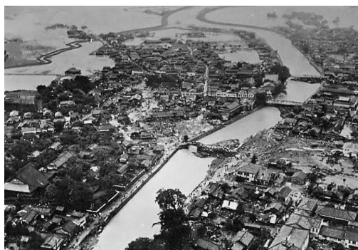
写真2-1 被災した諫早市街地の状況 出典) 本明川水系河川整備計画(変更) 3)
