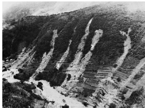
写真2-5 本野大林付近の山津波のあと 出典) 長崎工事五十年のあゆみ(建設省) 1)
