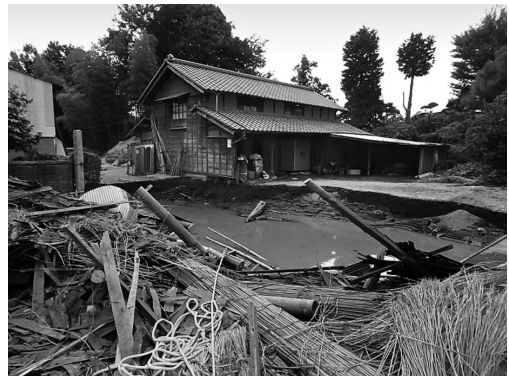
写真4 若宮戸の民家の深掘 (1) (9月16日撮影)
