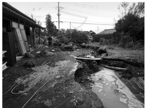
写真5 若宮戸の民家の深掘 (2) (9月16日撮影)
