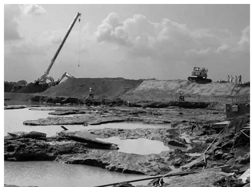
写真6 破堤点付近の深堀 (9月15日撮影)
