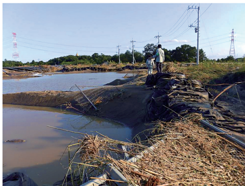
写真2 越流箇所状況(2015年9月11日撮影)
