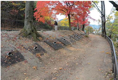
写真2-4 第1疏水第2トンネル東口近くに施工された、疏水堤体斜面のロックボルトによる安定化工（撮影：2014年11月23日）
