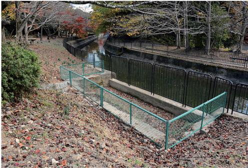
写真2-3 左から第1疏水に合流する、第2トンネル東口近くの溪流末端に設けられている沈砂池（撮影：2014年11月23日）
