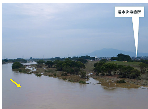
写真1 鬼怒川・常総きぬ大橋上流左岸の砂州と樹林（右遠方は堤防決壊箇所，2015.9.13執筆撮影）
