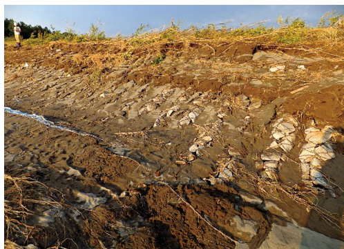
写真4 若宮戸地区の無堤防溢水箇所の表法護岸から出現した蛇籠工(写真3①25.35k付近、筆者撮影)
