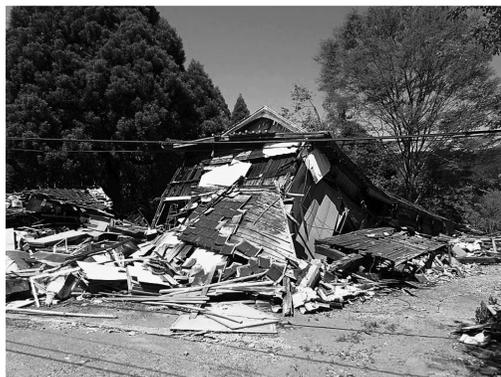
写真5 震度5強で「倒壊」による犠牲者が発生したと推定される場所
