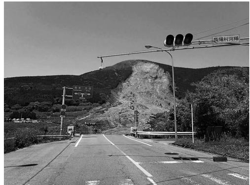
写真4 行方不明者が生じたと推定される阿蘇大橋付近の斜面崩壊(図3のb地点)
