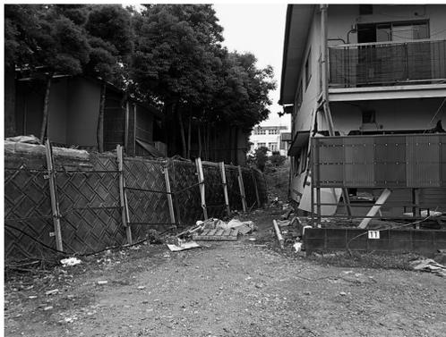
写真6 左手石垣上にあった高さ約2mのブロック塀が倒壊し、写真中央付近で犠牲者が発生と推定される。
