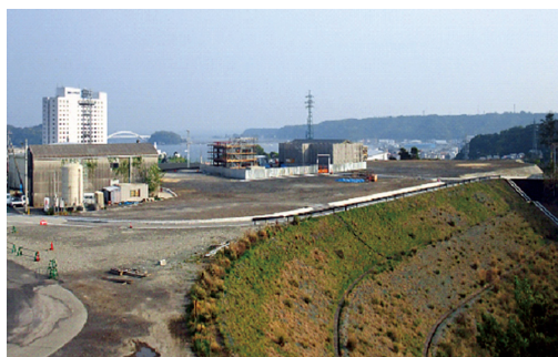
図11 公共施設の高台移転用造成地(海拔60m)
