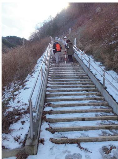
写真2 降雪と融雪を繰り返して氷状路面となっている避難路階段(2012年12月11日, 岩手県岩泉町)
