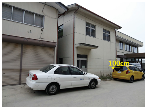
写真14 常総市役所別棟の浸水痕跡 (2015年9月16日撮影)
