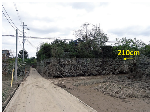
写真9 農家の屋敷林に残る浸水痕跡 (2015年9月16日撮影)
