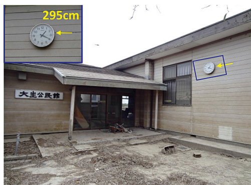
写真11 大生公民館の浸水被害 (2015年9月16日撮影)
