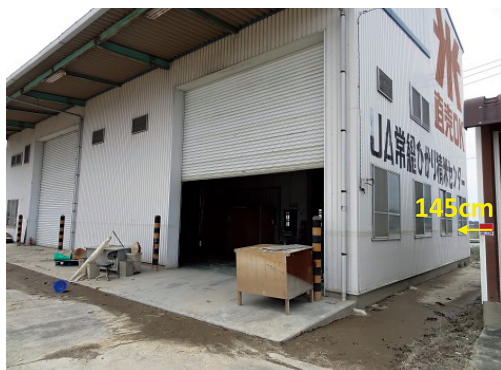
写真7 JA常総ひかり精米センターの浸水被害 (2015年9月16日撮影)
