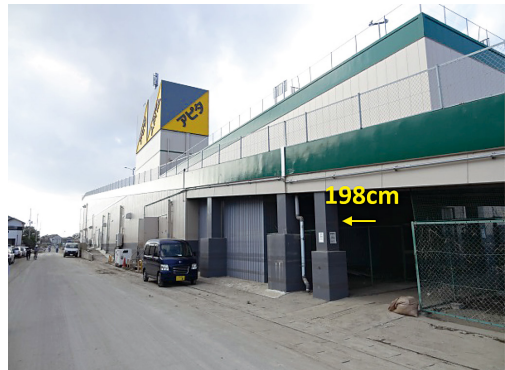
写真4 スーパーマーケットの浸水被害 (2015 年9月15日撮影)
