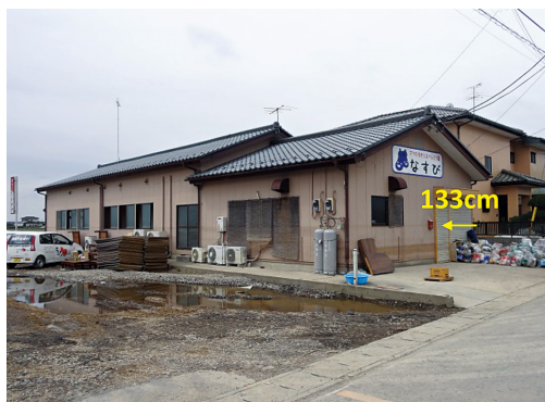
写真6 食品店舗の浸水被害 (2015年9月15日撮影)
