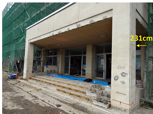
写真12 大生小学校の浸水被害 (2015年9月16日撮影)
