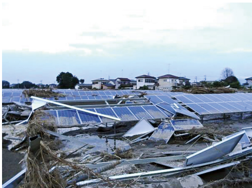
写真3 太陽光発電施設の浸水被害 (2015年9 月15日撮影)
