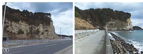
写真 1 久慈湾内における海岸線の様子（2013 年 11 月撮影）夏井地区（①）、麦生地区（②）
