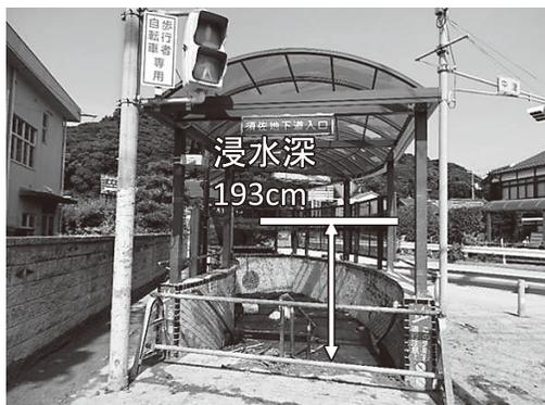
写真3 須佐地下道における洪水被害の状況（須佐地区，2013年7月31日撮影）
