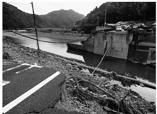
写真12 県道14号における高岩橋の落橋被害（萩市中小川，2013年7月31日撮影）
