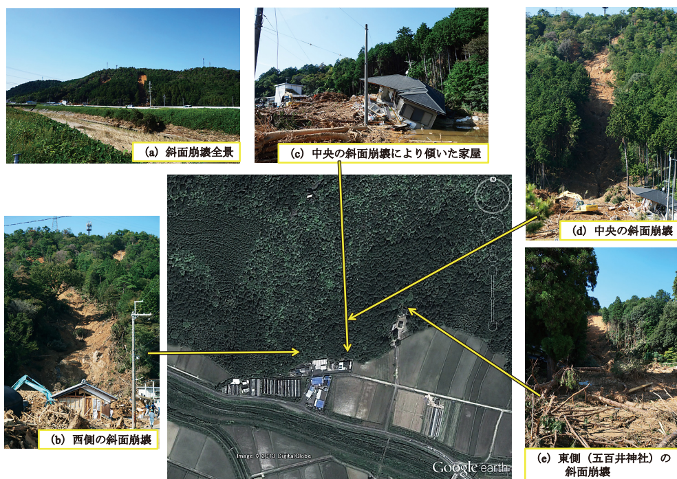
図14 栗東市下戸山地区の斜面崩壊
