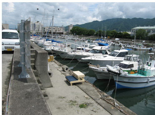
写真2 沿岸部の状況
