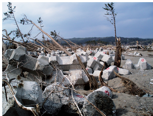
写真3 岩手県野田浜海岸・防潮堤・防潮林帯の損壊 (2011.4.26 著者撮影) 長さ1,300mの防潮林(黒松)幅約100m、 計画津波高T.P+12.0m、現況T.P+7.8m 侵食・計画・現況 T.P+10.3m 浸水深10m以上(推定) 遡上高16.9~19.0m
