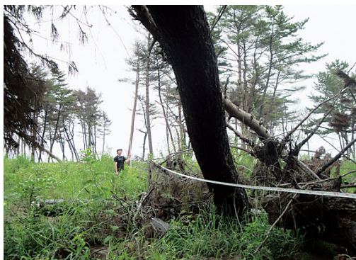
写真5 荒浜海岸周辺の防潮林調査 (2011. 8. 23) (著者撮影) 破断、倒伏した防潮林、遠方は海浜。樹幹部の破断箇所は地表面よりおおむね1~2m付近に見られる。
