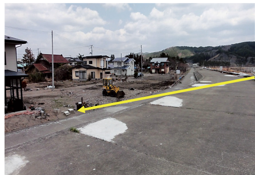
写真2 岩手県久慈川河口防潮堤左岸から下流を望む。遠望の防潮林の残存している背後地の家屋は被害が比較的小さい。手前は津波が直撃した家屋跡。矢印は津波侵入方向(著者撮影)
