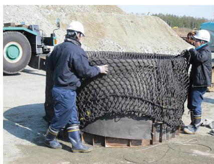
(1) 円形型枠に網をかぶせる
