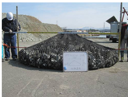
(4) 網式消波材の成型
