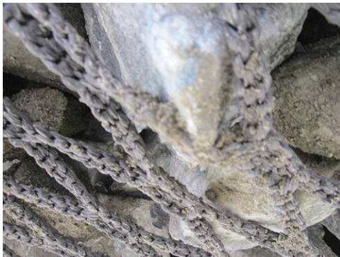
写真3 網式消波材の破損箇所
