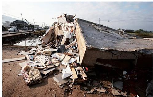
写真7 基礎部分から建物が転倒した住家被害 (2012年5月18日撮影)
