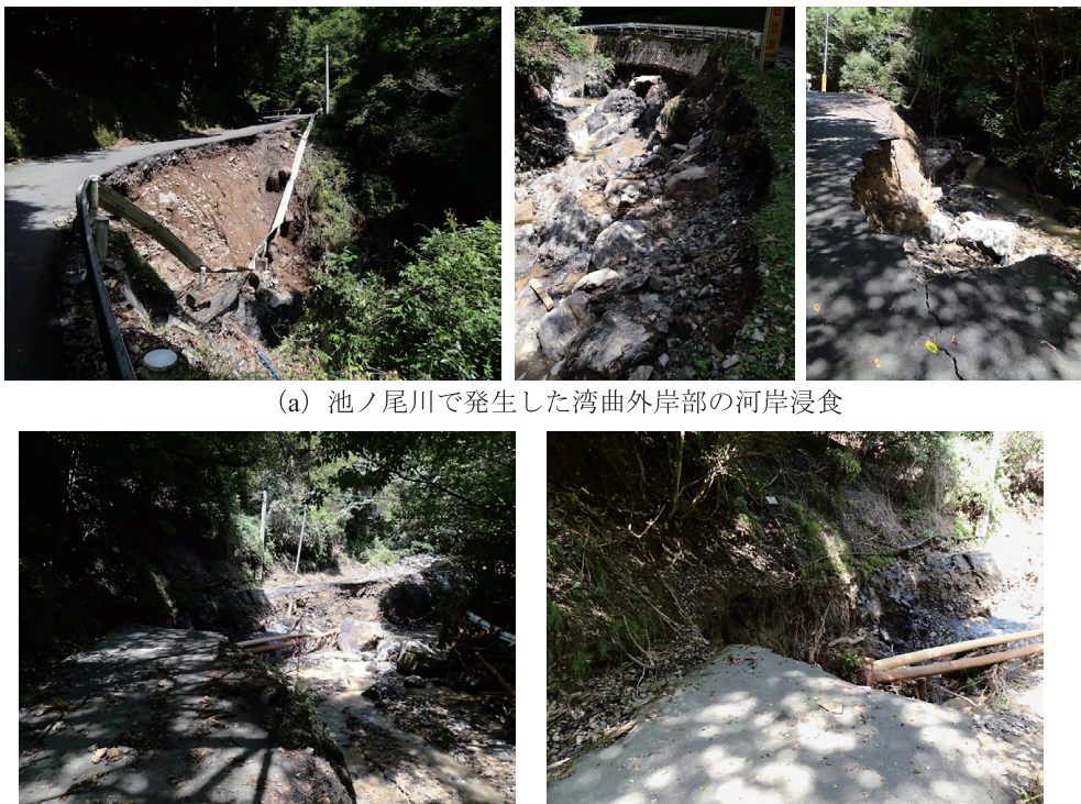
図8 池ノ尾川上流域の被災状況
