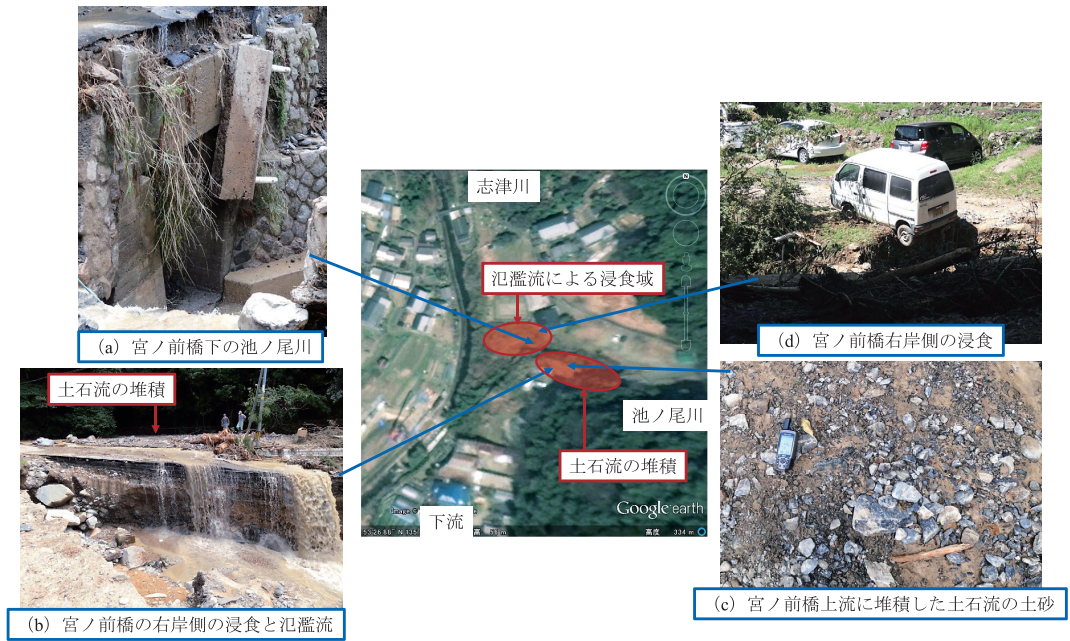
図7 志津川と池ノ尾川の合流点付近の被災状況
