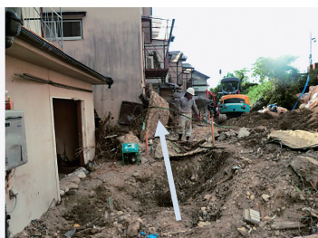
(c) 倒壊した堤防壁
