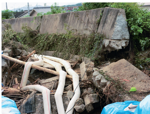
図23 ポンプによる排水（8月15日）
