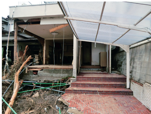
図21 泥流の通り道となった家屋（8月15日）
