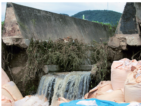
図22 河川堤の破断面（8月15日）
