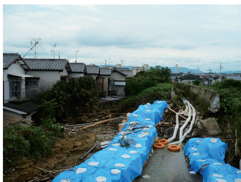
図18 弥陀次郎川の破堤箇所全景（8月15日）
