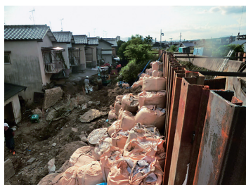
(a) シートパイルの施工
