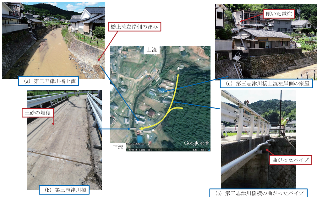
図9 第三志津川橋周辺の被災状況
