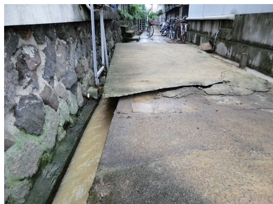
(a) 路地内の地盤のめくれ
