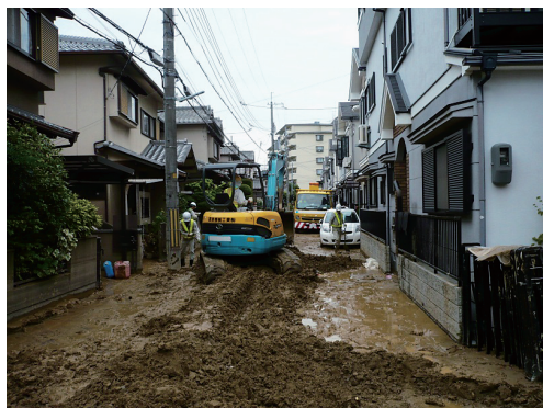
図19 氾濫した土砂の堆積（8月15日）
