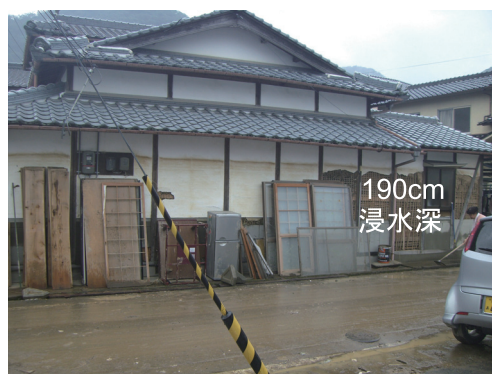
写真14 久崎地区における洪水被害の状況 (佐用町久崎，2009年8月11日撮影)
