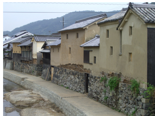
写真2 平福地区の作用川に面した土蔵群における洪水被害の状況（佐用町平福，2009年8月29日撮影）
