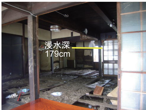
写真9 上月地区における住家の洪水被害の状況 (佐用町上月, 2009年8月11日撮影)
