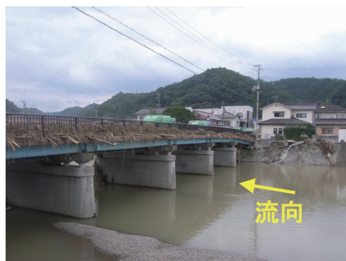
写真3 佐用地区の佐用大橋における欄干への流木の痕跡 (佐用町佐用、2009年8月11日撮影)
