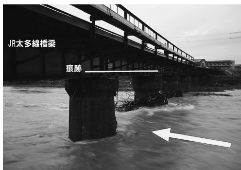
写真10 JR 太多線橋梁水位痕跡（7月16日朝） 5)
