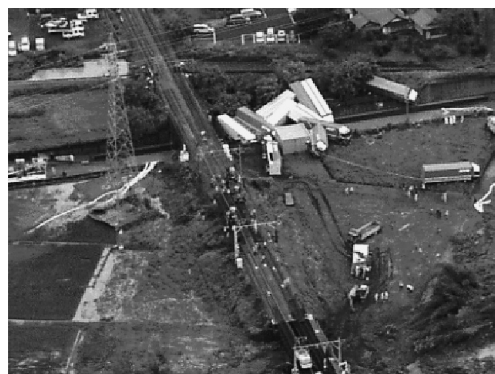
写真4 氾濫によってアンダーパス部に集積したトラック (7月16日) 4)
