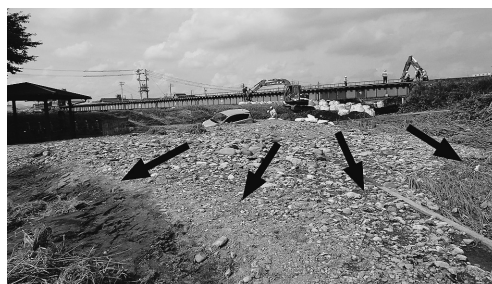
写真13 破堤部堤内側の様子 その1（7月16日）
