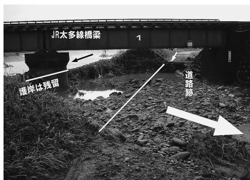
写真11 左岸破堤部の様子（7月16日朝） 4)
