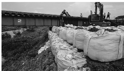
写真12 破堤部復旧の様子（7月16日夕）
