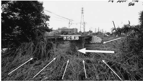
写真5 名鉄橋梁上流側を左岸から見る（7月17日）
