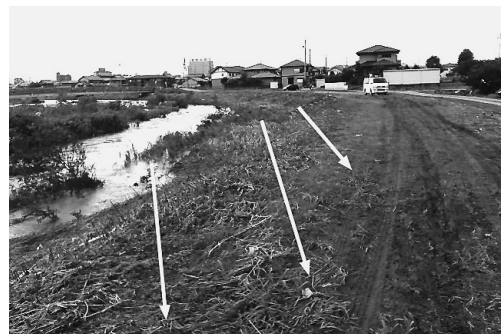
写真9 6.7km 付近右岸, 越流痕跡(7月16日)
