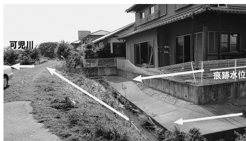
写真16 被災家屋と氾濫水の河川復帰部（7月16日）
