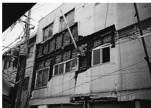
図14 外壁の脱落
