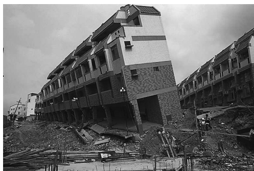
図18 断層変位による建物の傾斜（台湾集集地震）
