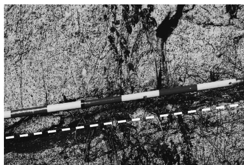
写真10 No. 31の水平方向のクラックの状況 地上から約1.5mの高さで流れ盤方向 に約5°のクラック(破線)の発達状況
