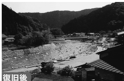
写真4-4 上村川 復旧後 (上矢作町本郷)
