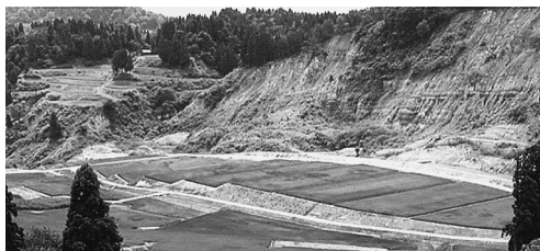
[復旧後] 斜面下部の土砂は均され、区画は大型化された
