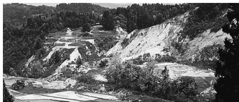
[被災状況] 崩落した土砂が下部の農地を埋め、河川を塞いだ
