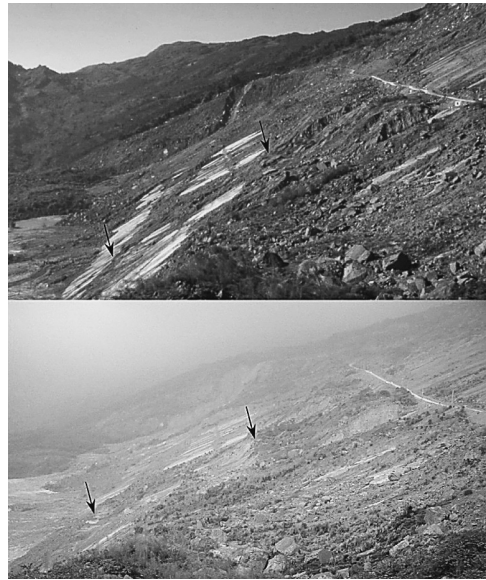
図4 九分二山の崩壊にみられた地層の座屈。上：2000年11月14日撮影。下：2002年3月14日撮影。矢印が座屈を示す。下の写真では座屈部分の突出が明瞭になっている。
