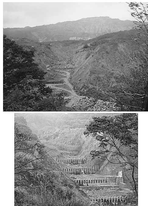
図5 九分二山の土砂ダムの侵食状況(上、2002年3月14日撮影)と対策状況(下、2007年11月29日撮影、スリット型ダム)。
