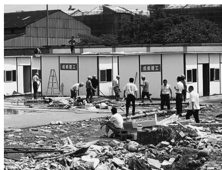
写真8 都江堰市の仮設住宅建設作業
