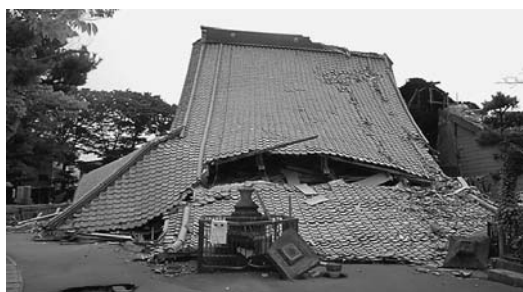
2007年新潟県中越沖地震で崩壊した寺院
