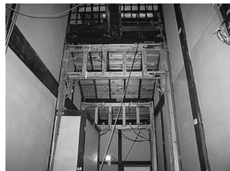
写真3-4 はしご型フレームによる補強
