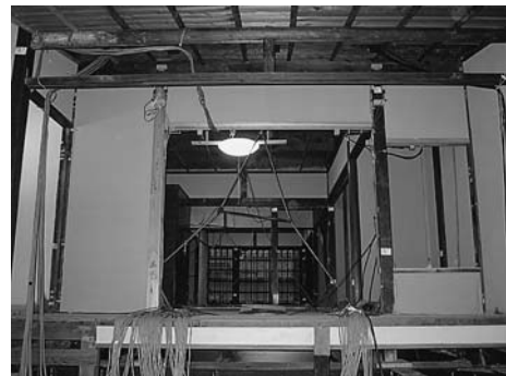
写真3-3 乾式土壁による補強
