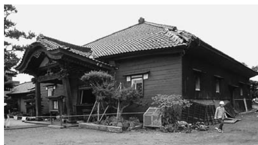
2007年新潟県中越沖地震で大破した寺院
