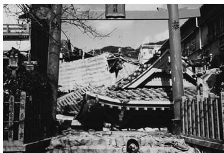
1995年兵庫県南部地震で崩壊した神社
