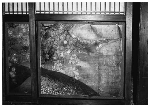
写真5-7 兵庫県尼崎市の寺院、絵画の被害は障子のゆがみが原因(1995年)
