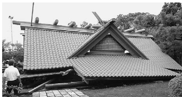
2007年新潟県中越沖地震で崩壊した神社
