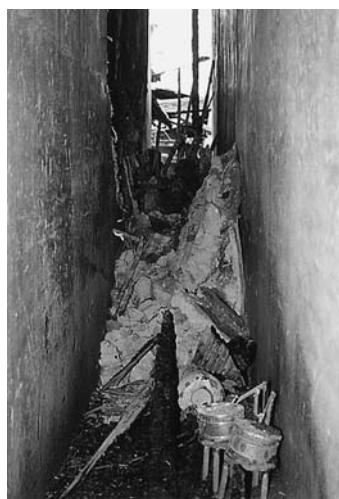
写真4-2 高山市三町・火災(1996)消火放水で壁 が崩落し消防進入路をふさいでいる。
