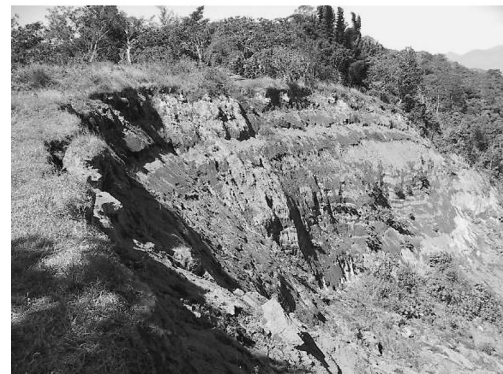
図6-4 発生直後のラスコリナス地すべり全景と滑落崖
