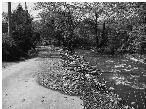
写真2 犠牲者自宅付近 図6のB地点付近。2006年10月17日筆者撮影。川は元町川。仮復旧されているが、道路の土砂を積み上げた部分は災害時には浸食された。
