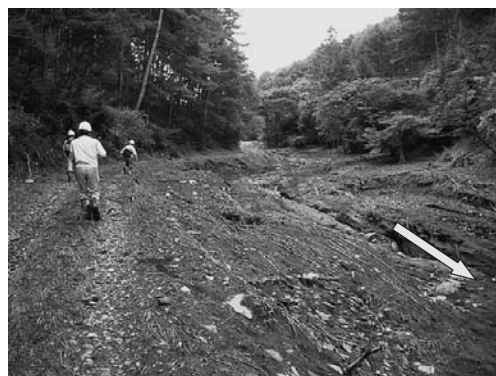
写真3 志平沢川流下部の渓床の状況
