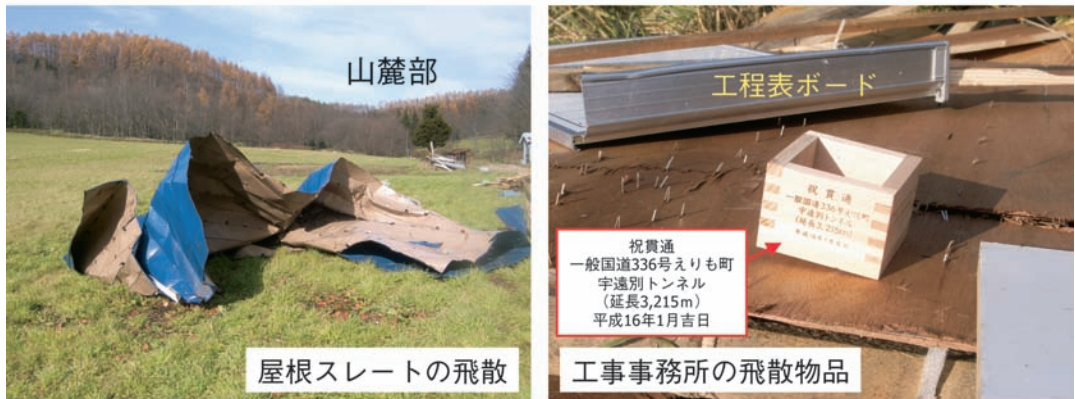
写真7 竜巻による飛散物 (2006年11月9日撮影)
