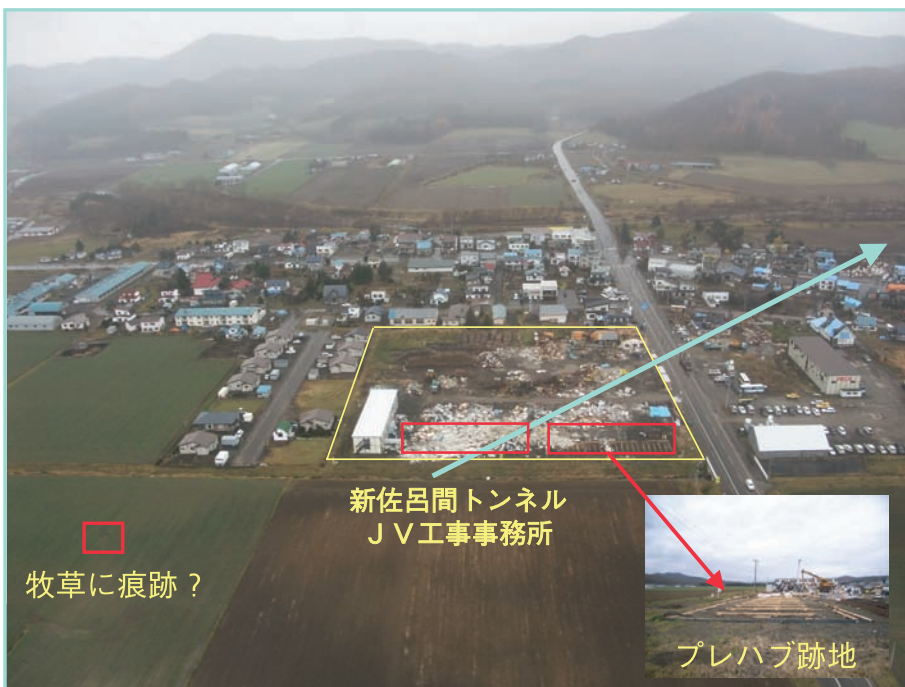
写真3 新佐呂間トンネルJV工事事務所および周辺の被害 (2006年11月10日撮影)
