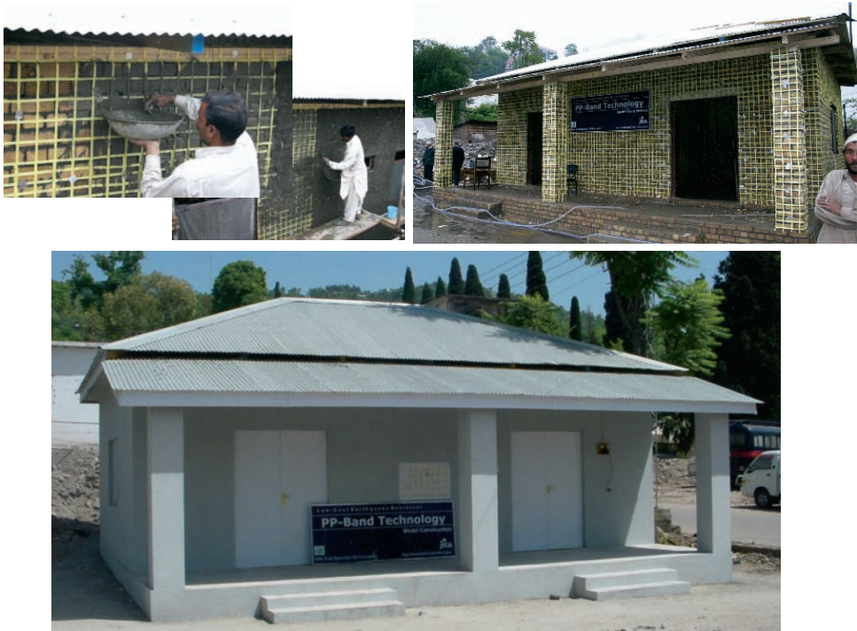
図8 提案手法で補強した実構造物 (上段：建設途中，下段：竣工時の外観)
