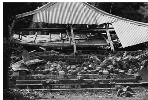
(c) Non-E建物の被災例(a2,b1タイプ)
