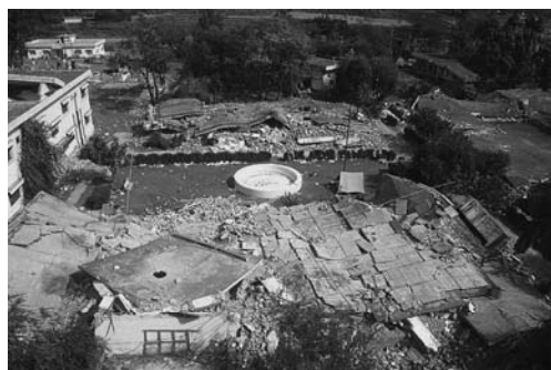
(b) Non-E建物の被災例(a1,b1タイプ)
