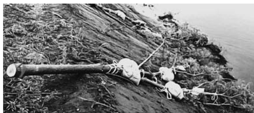
図4-3 木流し工の実施風景 (北海道開発局提供)
