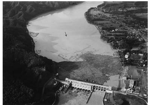
図4-8 平成15年洪水において二風谷ダムに捕 捉された流木の状況 (北海道開発局提供)
