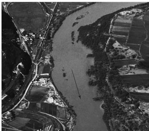
図4-4 米代川における柳水制 (写真：国土交通省の能代河川国道事務所提供)
