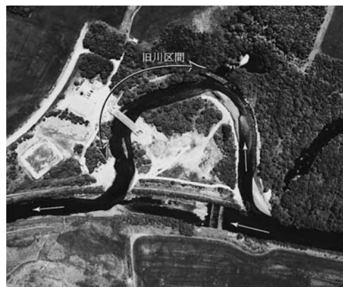
図4-6 標津川蛇行復元試験区の通水から3ヵ月後の状況
