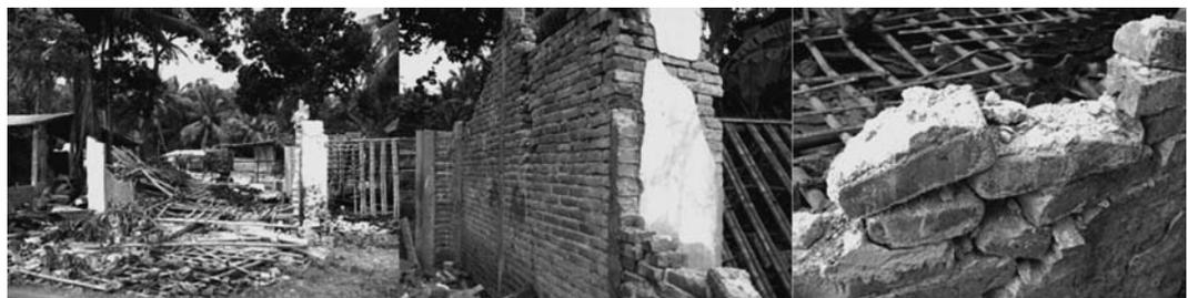
写真-15 倒壊家屋の構造 (Pandak)
