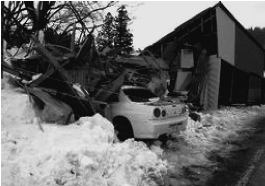
図8 雪の重みで車庫が倒壊し、男性1人が亡くなった現場 (1月14日、新潟県妙高市長沢) 7)
