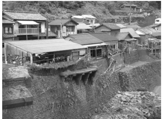
写真3 洪水流により損壊した宮崎県日之影町神影地区の民家 右から2軒目の民家は土台から浮き上がり、移動している。2005年9月10日、牛山撮影。
