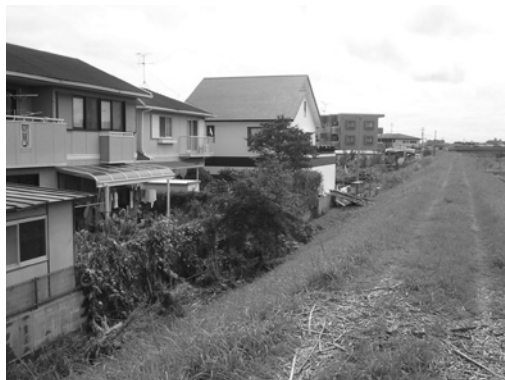
写真1 溢水が生じた宮崎市小松地区の大谷川 右側が河道。手前の堤防上のゴミから（堤防高は手前側が高く奥側が低い），この付近で越水があったことが推測される。 2005年9月11日，牛山撮影。
