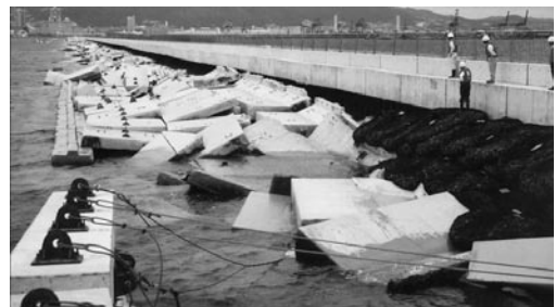
写真2-3 遮水護岸前面側の方塊コンクリートの崩壊
