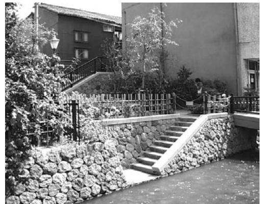
写真3-2 金沢市の用水護岸整備の例
