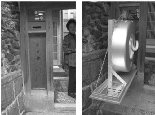
写真3-6 易操作性消火栓の例
