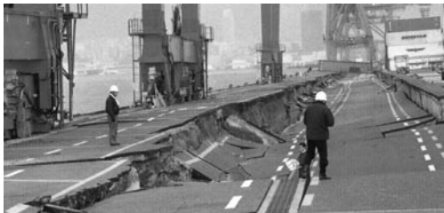
写真2-1 液状化による護岸構造物の被害
