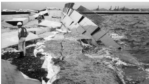
写真2-2 遮水護岸の背面側への倒壊
