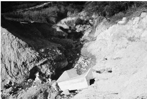
写真 4-4(b) 滑落した井出口池の洪水吐
