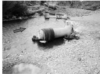
写真 2-5 鉄道橋梁の被害例
