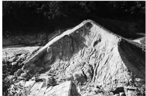
写真 4-4(a) 決壊した井出口池 (手前がもとの洪水吐取付部)
