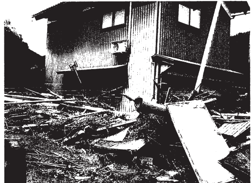
写真3 洪水流と流木により損壊された家屋。福井市安波賀中島町。
