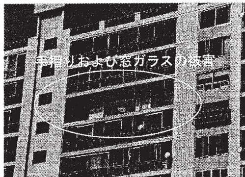
写真4 高層集合住宅①の手摺りおよび窓ガラスの被害
